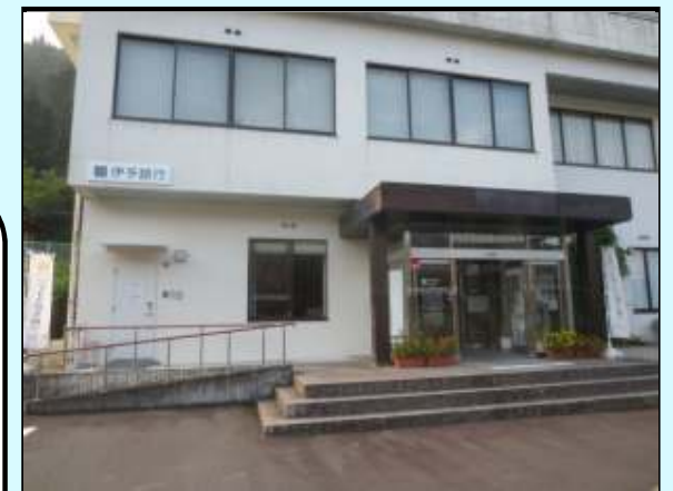
役場支所へ移転後の銀行支店
