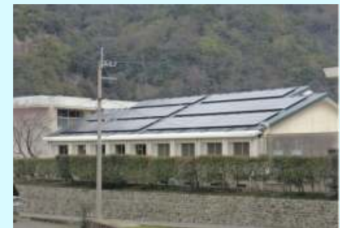
設備設置後状況(双海中学校)
