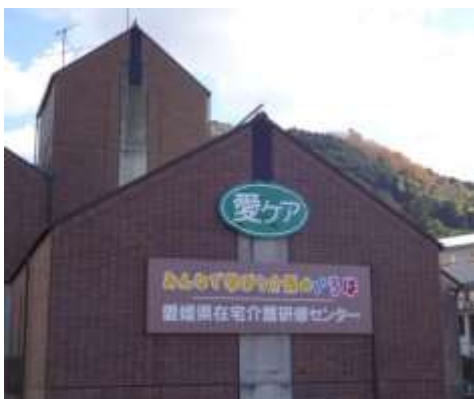
(在宅介護研修センター(愛ケア)外観)
