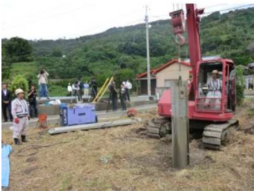
写真-2.1 地層試料採取の方法
