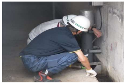
漏水量の計測
