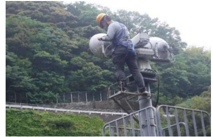
照明設備の点検
