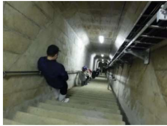
ダムの中の通路（監査廊）を 通って放流設備に向います。
