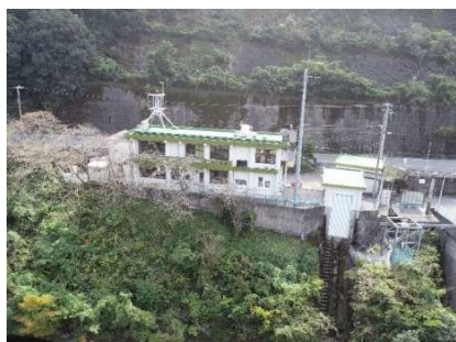
ダム管理の拠点でダムの左岸側にあります。
