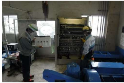
クレストゲートの点検
