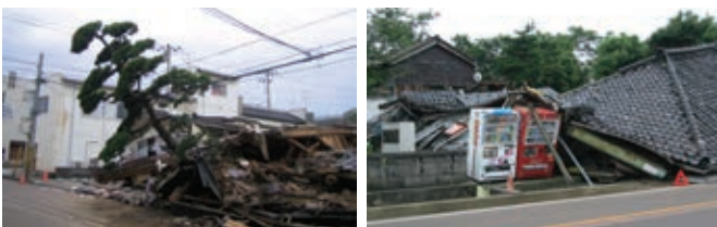
平成19年7月に発生した新潟県中越沖地震では、住宅1,088棟が全壊した。(写真提供：新潟県)
