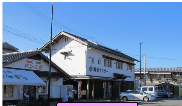
防災センター
