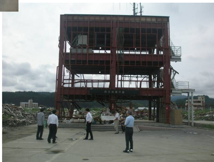
南三陸町防災対策庁舎
