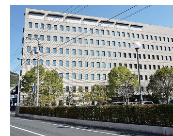
八幡浜支局庁舎(八幡浜市)
