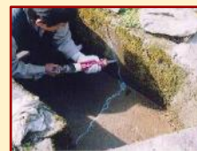
水路のひび割れ補修
