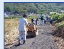
未舗装農道の舗装
