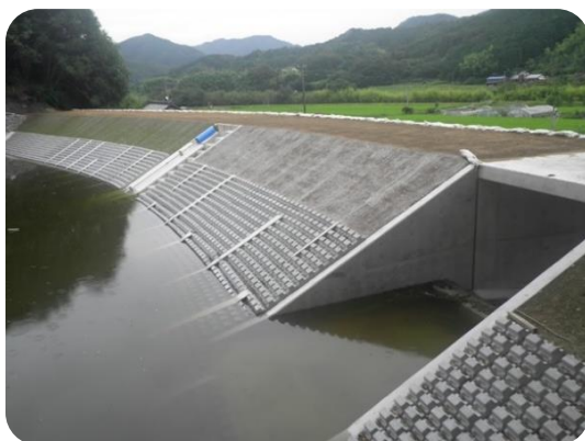
堤体を改修したため池（松野町）
