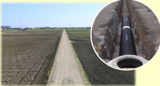
道路に埋設した排水管で降雨を排水
