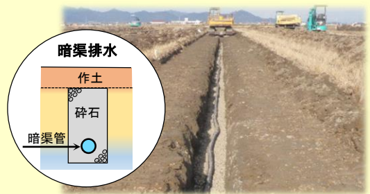
暗渠管を水田に埋設し地下水等を排除
