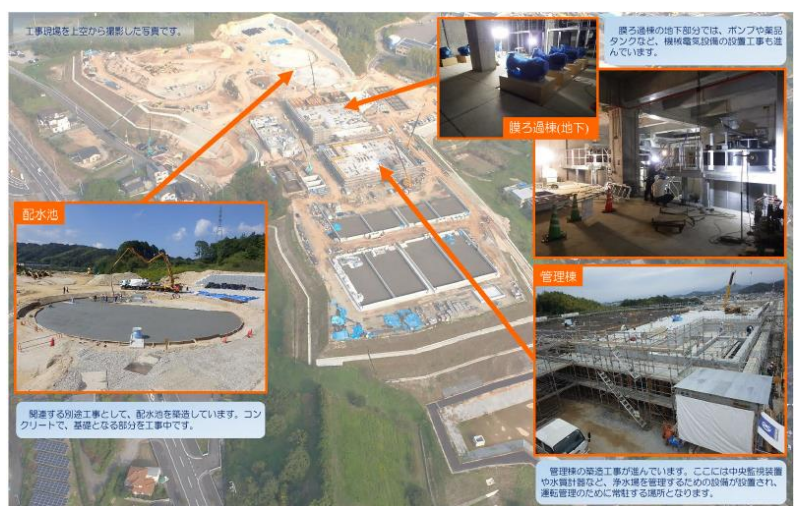
(仮称) 高橋浄水場整備事業（今治市）の進捗状況 <出典：今治市水道だより第5号> 8
