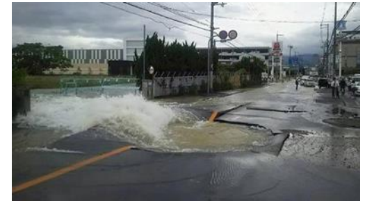
<大阪北部地震による送水管の破裂>
