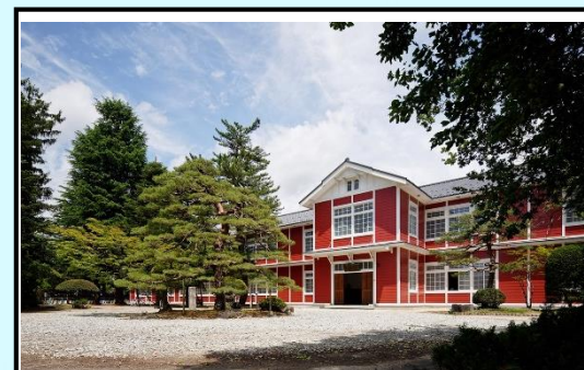
旧長井小学校第一校舎の外観
