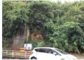
土砂崩れ注意箇所
