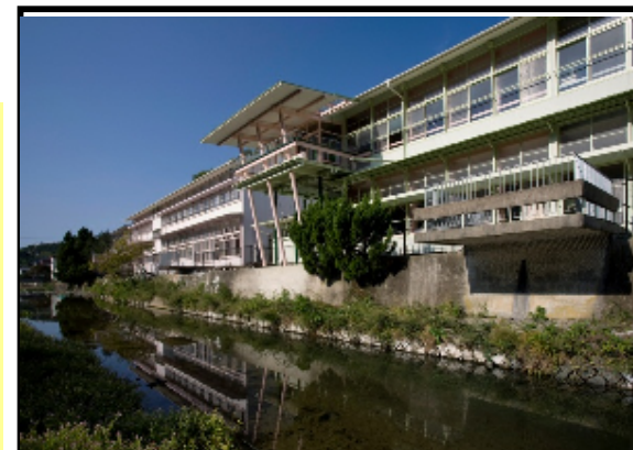
喜木川から日土小学校
