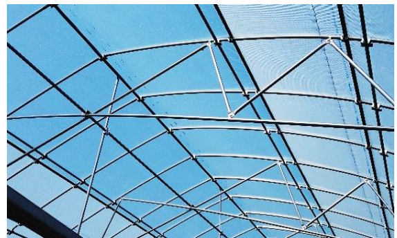
大型ハウスの強度を高める低コストの新トラス構造
