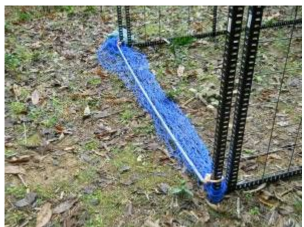
写真 9-6 引き上げ式ゲート(全体) (引き上げロープ未施工)
