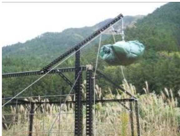
写真 9-2 ハンガーからの土嚢のつり下げ
