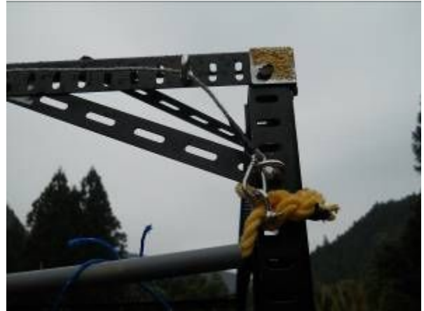
写真 9-4 引き上げ式ゲートロック構造
