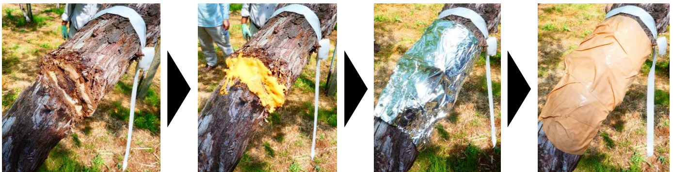
写真2 剥皮部削り直し
