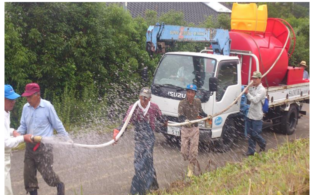
センチピードグラスの吹付け作業
