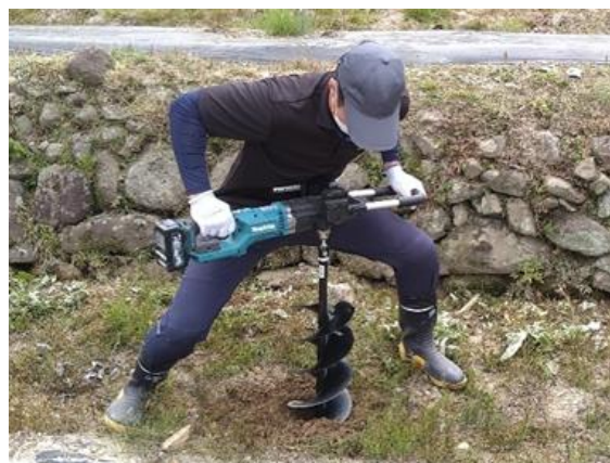
穴掘り機を用いた縦穴開け
