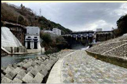
スタート地点：鹿野川ダム直下
