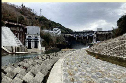
スタート地点：鹿野川ダム直下
