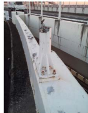
点検用開口部の破断による落下 (高架橋、設置後21年経過)
