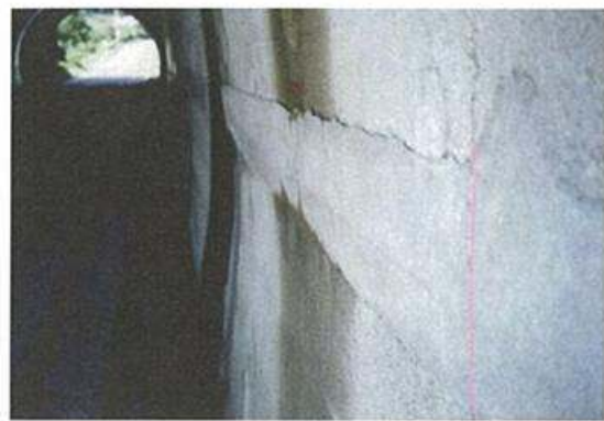
付写真-1. 1. 2 逆巻き工法の縦断方向打ち継目と化粧モルタルの施工状況
