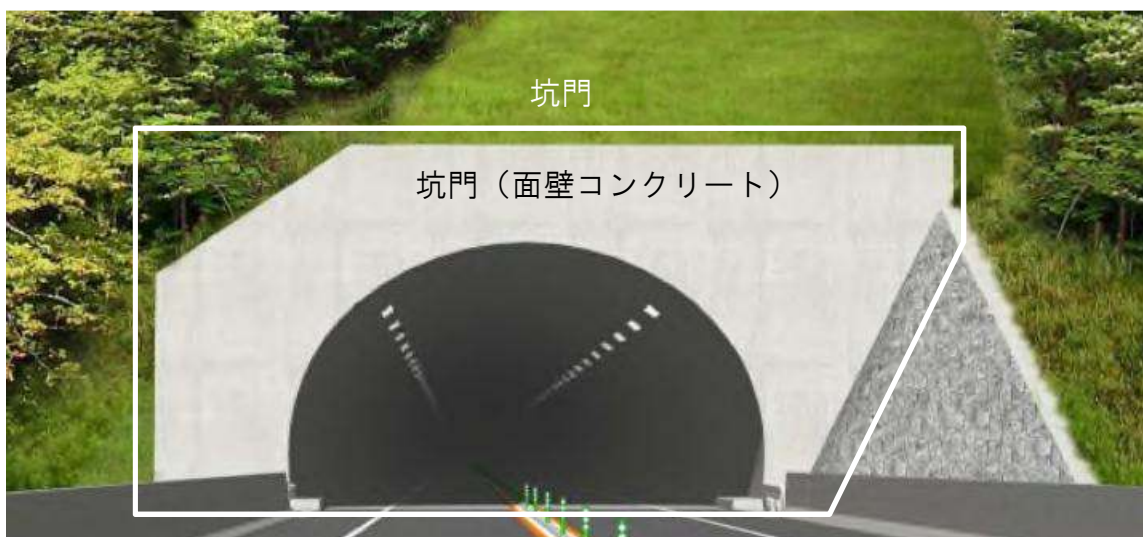
別図-1. 2 点検対象箇所（トンネル坑口部）
