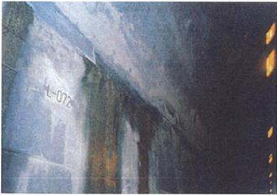
付写真-1. 1. 2 逆巻き工法の縦断方向打ち継目と化粧モルタルの施工状況
