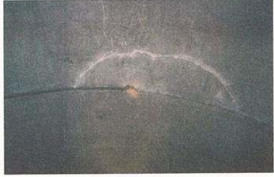
付写真-1. 1. 1 横断方向目地の天端付近に発生した半月状のひび割れの例
