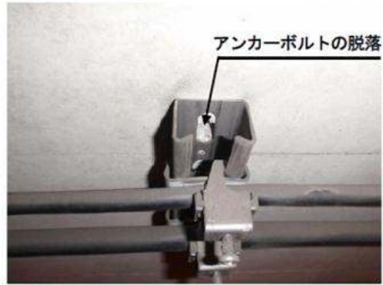
付写真-1. 5. 1 固定金具の腐食とアンカーボルトの脱落の例
