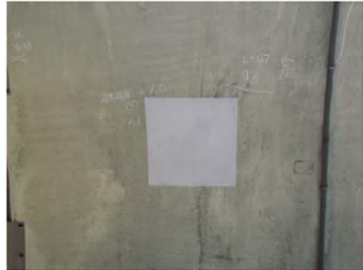
付写真-1. 4. 6 鋼板接着（左）・繊維シートの接着（右）例
