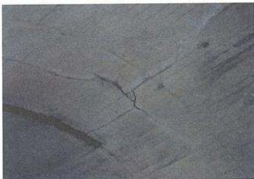
付写真-1. 4. 1 複数のひび割れで覆工コンクリートがブロック化している例
