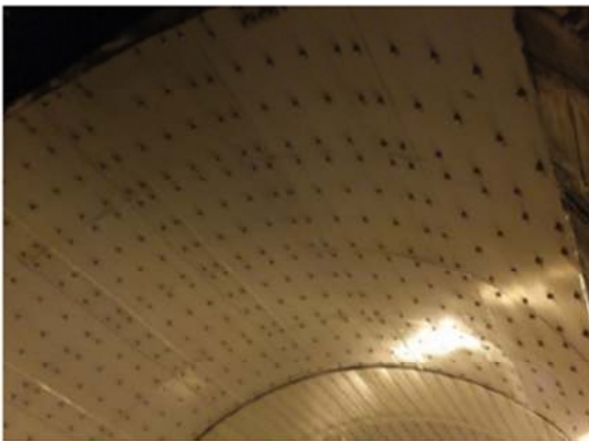
付写真-1. 4. 6 鋼板接着（左）・繊維シートの接着（右）例
