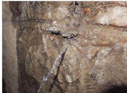
付写真-1. 4. 3 漏水（噴出）している例
