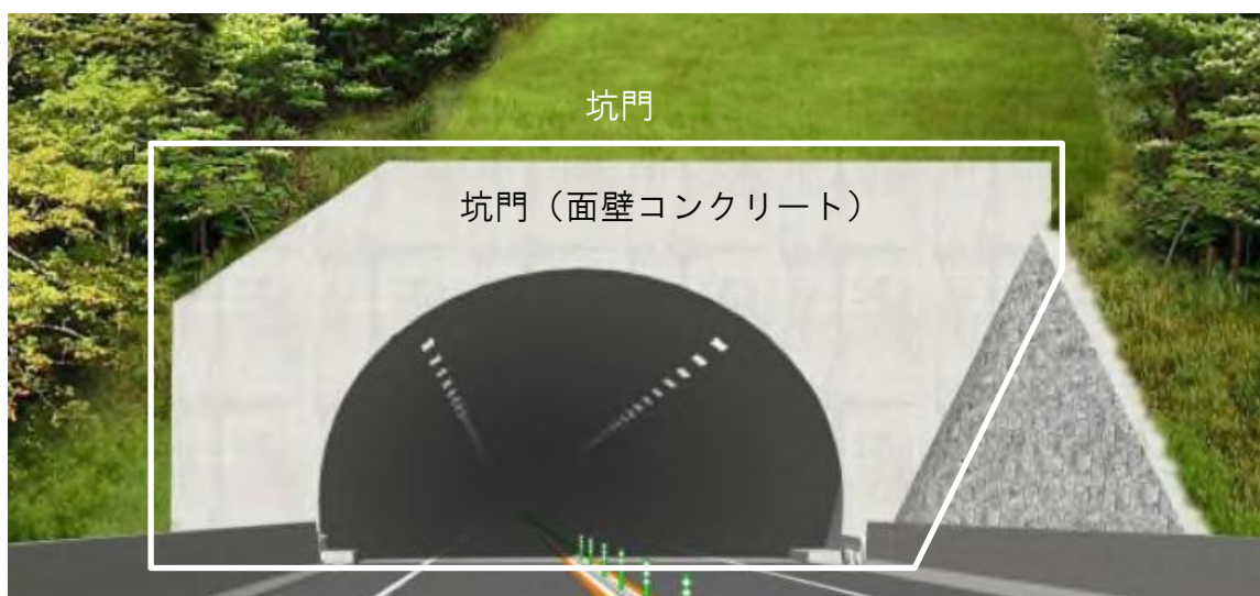
別図-1. 2 定期点検対象箇所为例 (トンネル坑口部)
