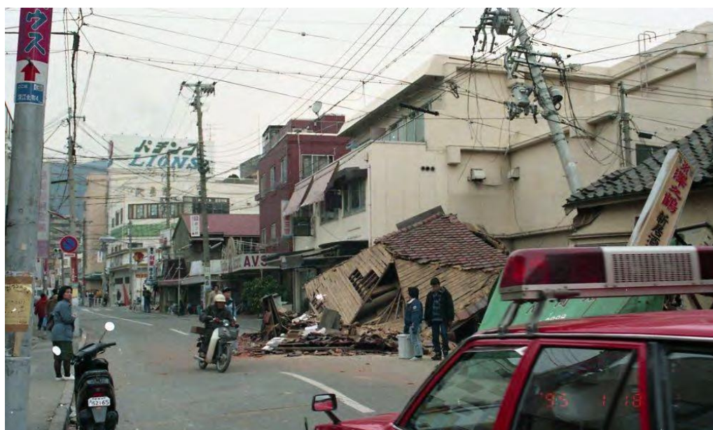
写真 電柱の破損事例
