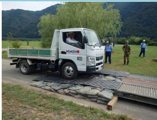
写真 土のうによる段差解消訓練
