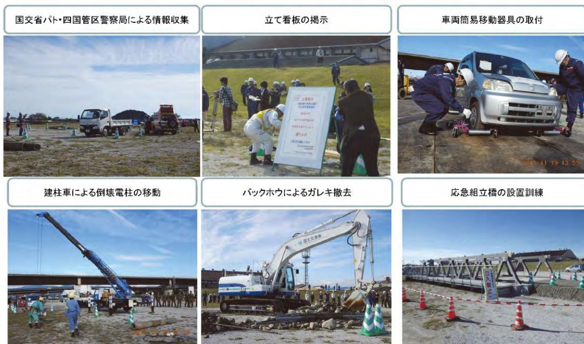
図 道路啓開実働訓練の状況
