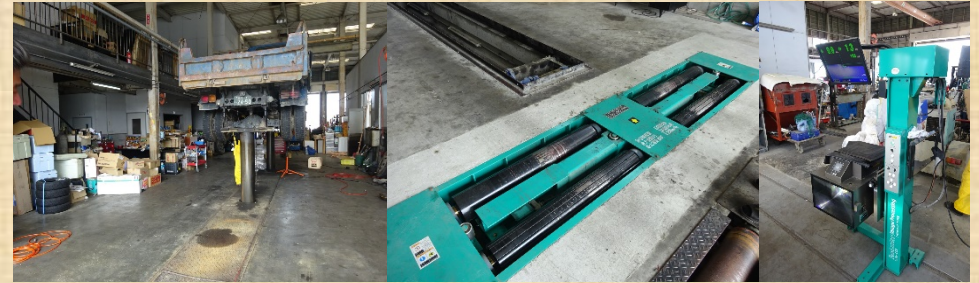
復旧後の工場内と修繕した設備
