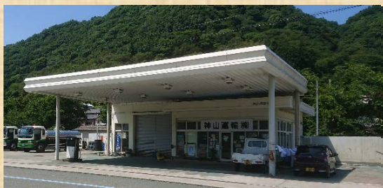
復旧後の写真
