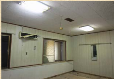
浸水時の客室
