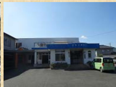
復旧後の外観
