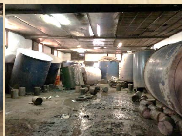
浸水により破損した貯蔵タンク
