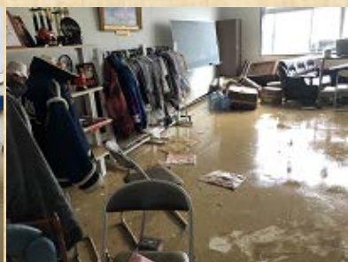
被災した工場内
