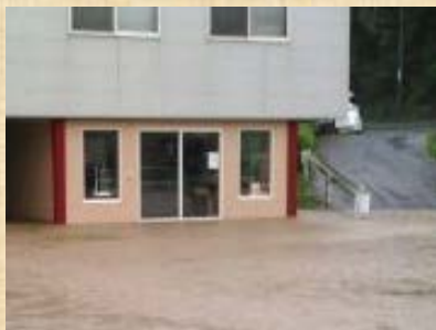
浸水した店舗部分
