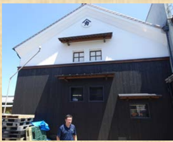
復旧後の土蔵
