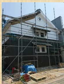
復旧途中の土蔵
