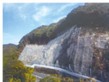
法面防災対策(落石防護工)
