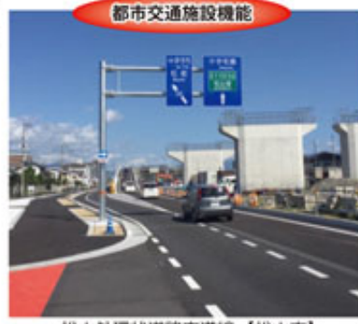
松山外環状道路空港線【松山市】
