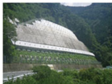
法面防災対策(アンカー工)
