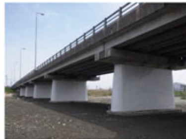
橋梁耐震対策(橋脚巻立工)
