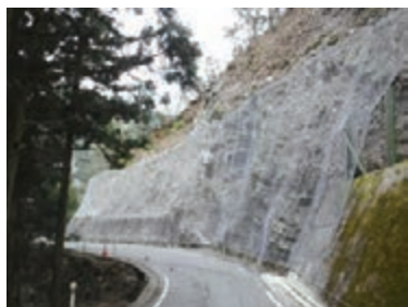
法面防災対策(ロックネット工)
