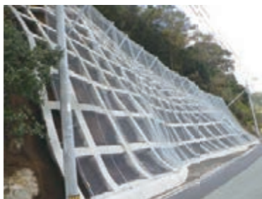
法面防災対策(法枠工+ロックネット工)
