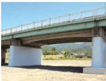
橋梁耐震対策(橋脚巻立工)
