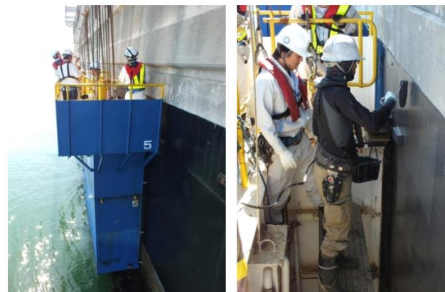
現場研修会：ケーソンライニング施工状況(北備讃瀬戸大橋)
