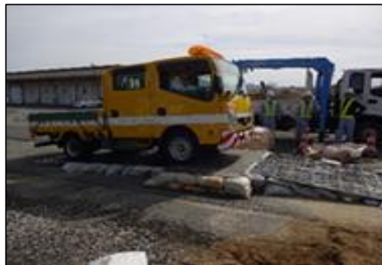
被災地への交通手段の確保 (保有資材の活用した路面段差修正訓練)
