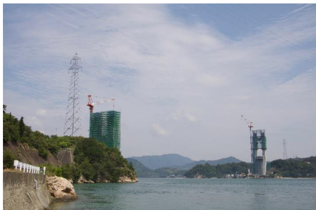
現場実習：斜張橋建設現場(岩城橋(愛媛県))
