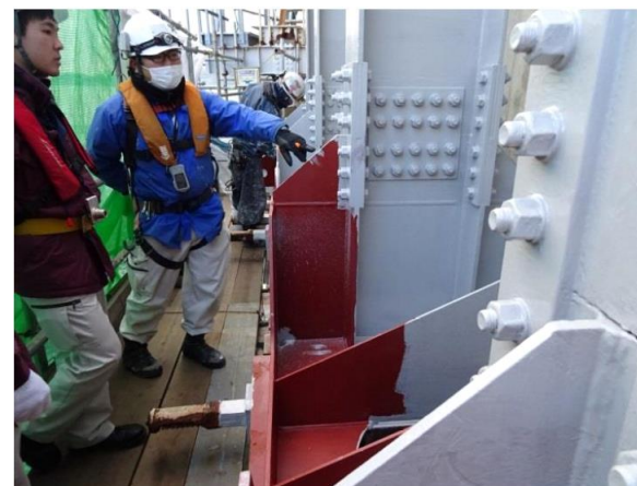
現場研修会：主塔基礎補修塗装施工状況(明石海峡大橋)
