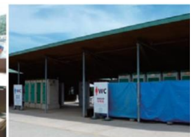
仮設トイレの設置 (男性用4基、女性用6基)
