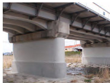
橋脚補強 (コンクリート巻立)
