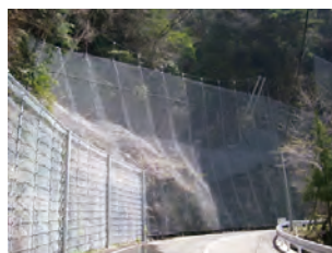
落石防止工 (落石防護網)
