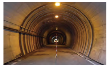
漏水対策工
