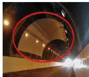
剥落防止工 (炭素繊維シート貼付け)
