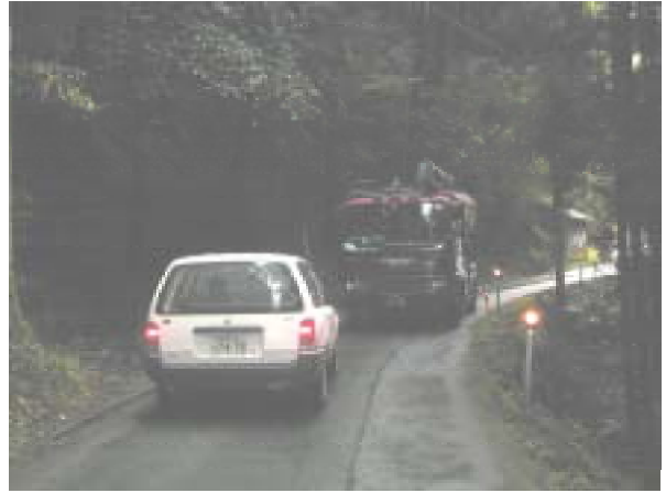
●中山間地の未改良の県道における離合困難な状況
