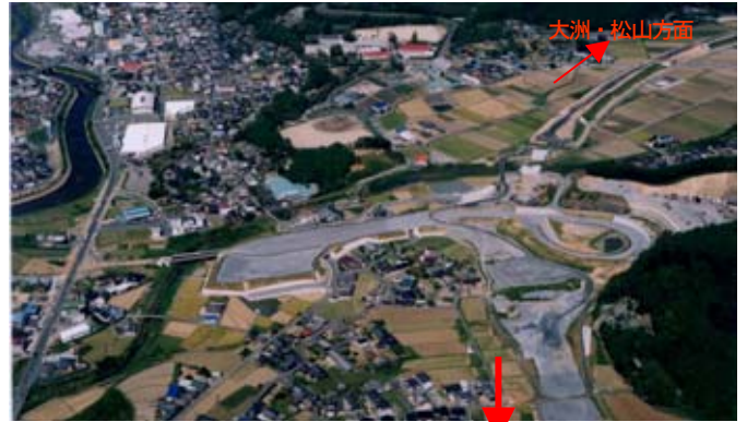
●整備中の高速道路:宇和IC(仮称)付近
