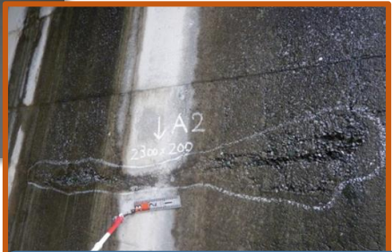
コンクリート補修工
