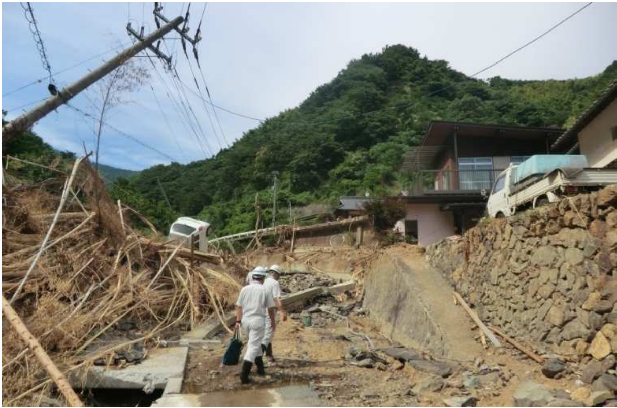
8月31日 17:30 応急復旧完了
