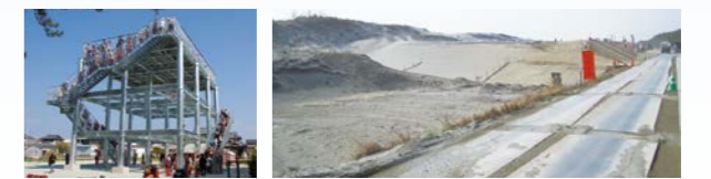
津波避難タワー 防潮堤の整備
