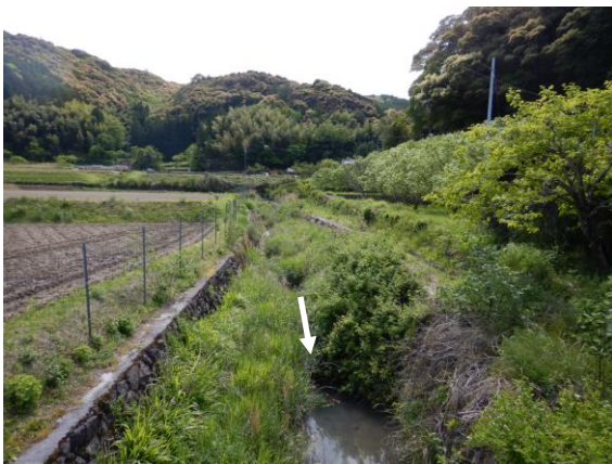
写真 6-3 未改修区間②
