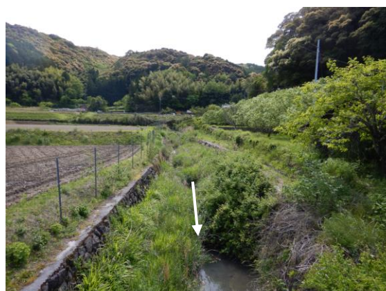
写真 4-6 未整備状況（上流部）
