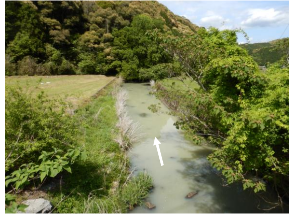
写真 6-2 未改修区間②
