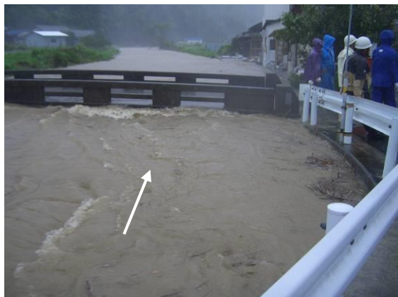
写真 3-3 浸水状況 (SP1700 付近)
