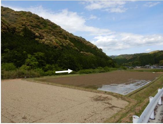
写真 6-1 未改修区間①
