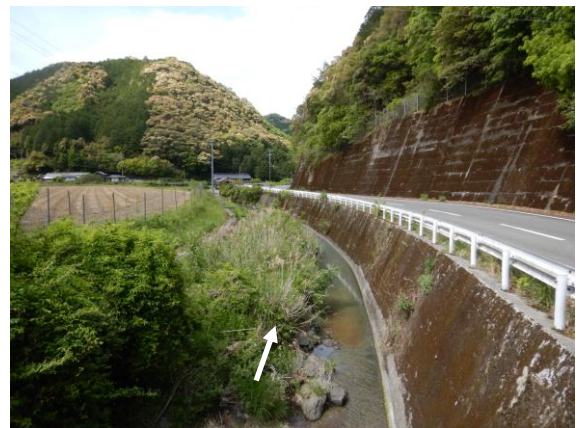
写真 6-4 未改修区間②
