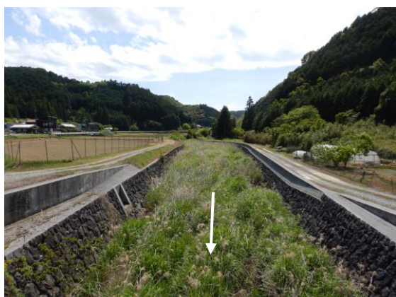
写真 4-5 整備状況（上流部）
