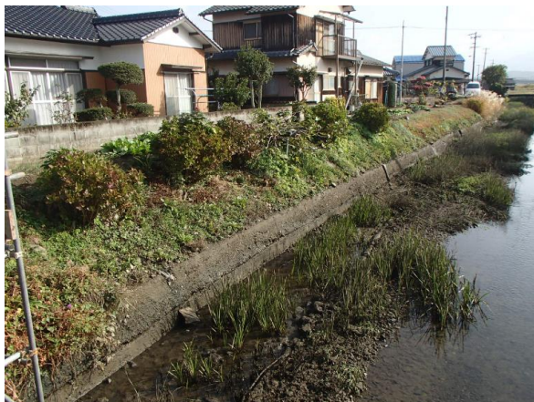
排水路の住宅隣接状況
