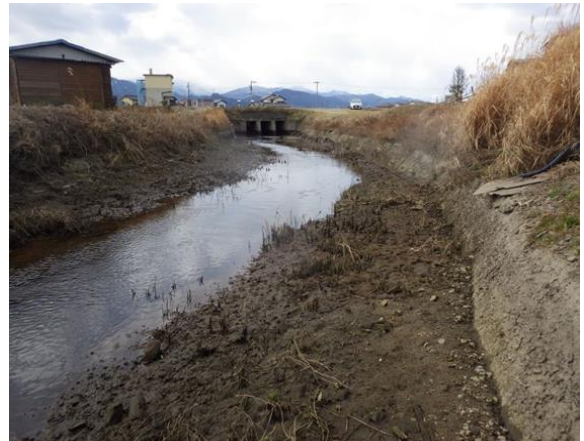
排水路法面の状況
