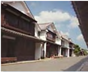
写真 2 西予市宇和町卯之町 伝統的建造物群保存地区
