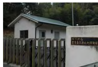
写真 10 阿下地区農業集落排水処理施設
