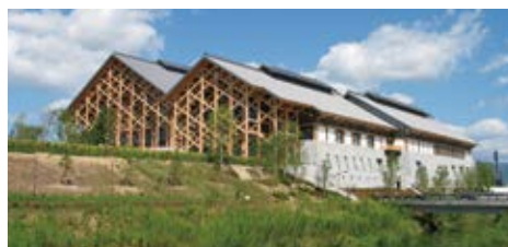
県内産の木材を用いた「愛媛県武道館」
