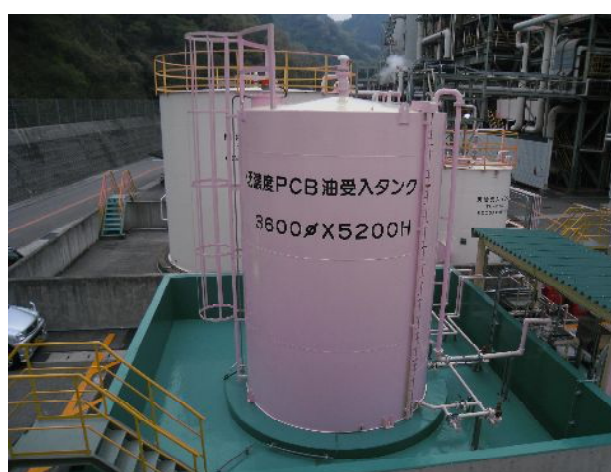
微量PCB汚染絶縁油専用保管タンク
