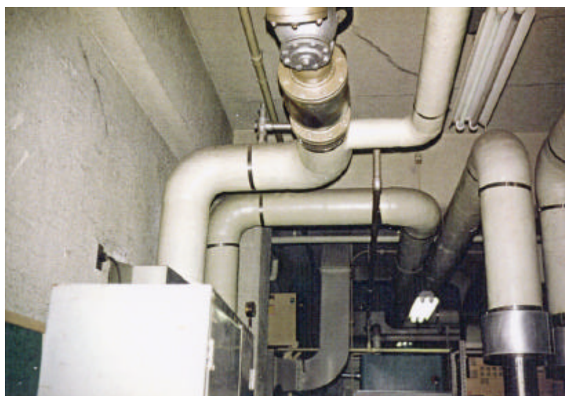
吸音・断熱（機械室 壁・天井）
