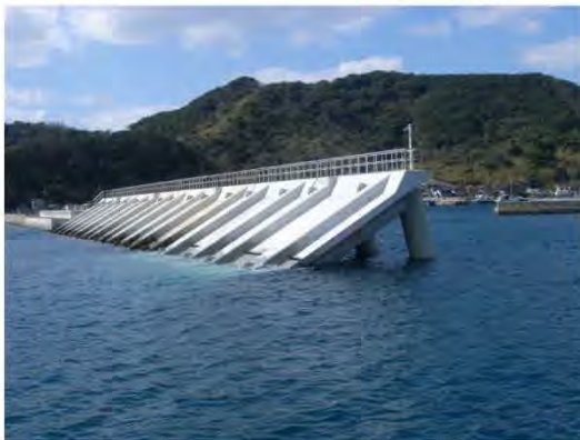
整備した防波堤(本浦漁港)
