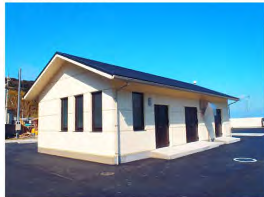
整備した集落排水施設(大成)
