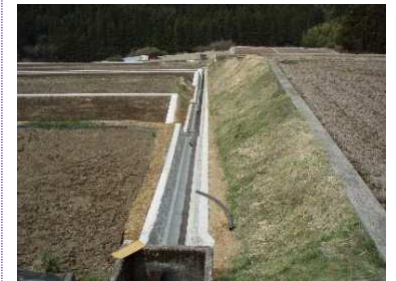
野地横通の水路改修
