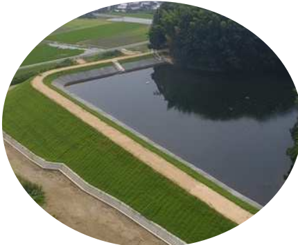
ため池の改修
