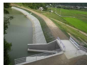
ため池の改修整備
