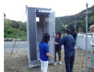
労働環境改善のための簡易トイレの設置
