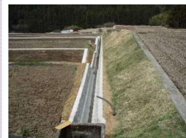
野地横通の水路改修
