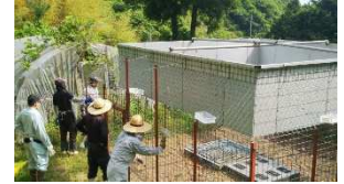
地獄檻の設置状況
