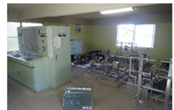
かんがい施設改修状況
