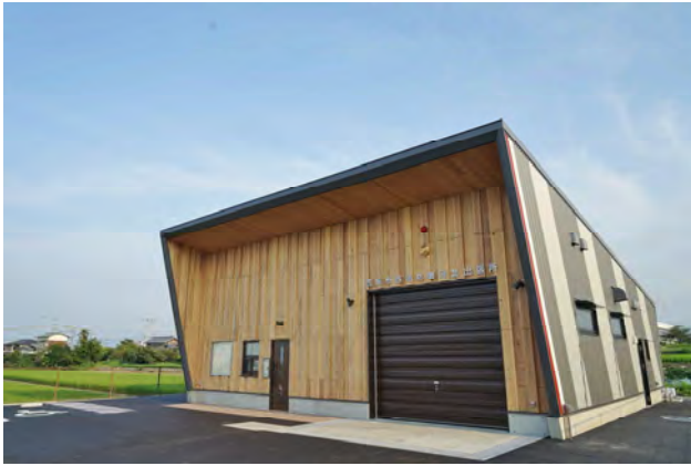
西条市西消防署河北出張所
