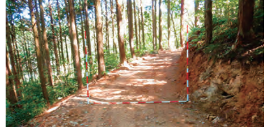
森林作業道の改良
