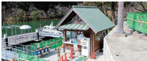
小屋の改修工事
