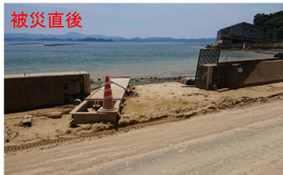
南君漁港【宇和島市】 陸閘復旧 N=1式
